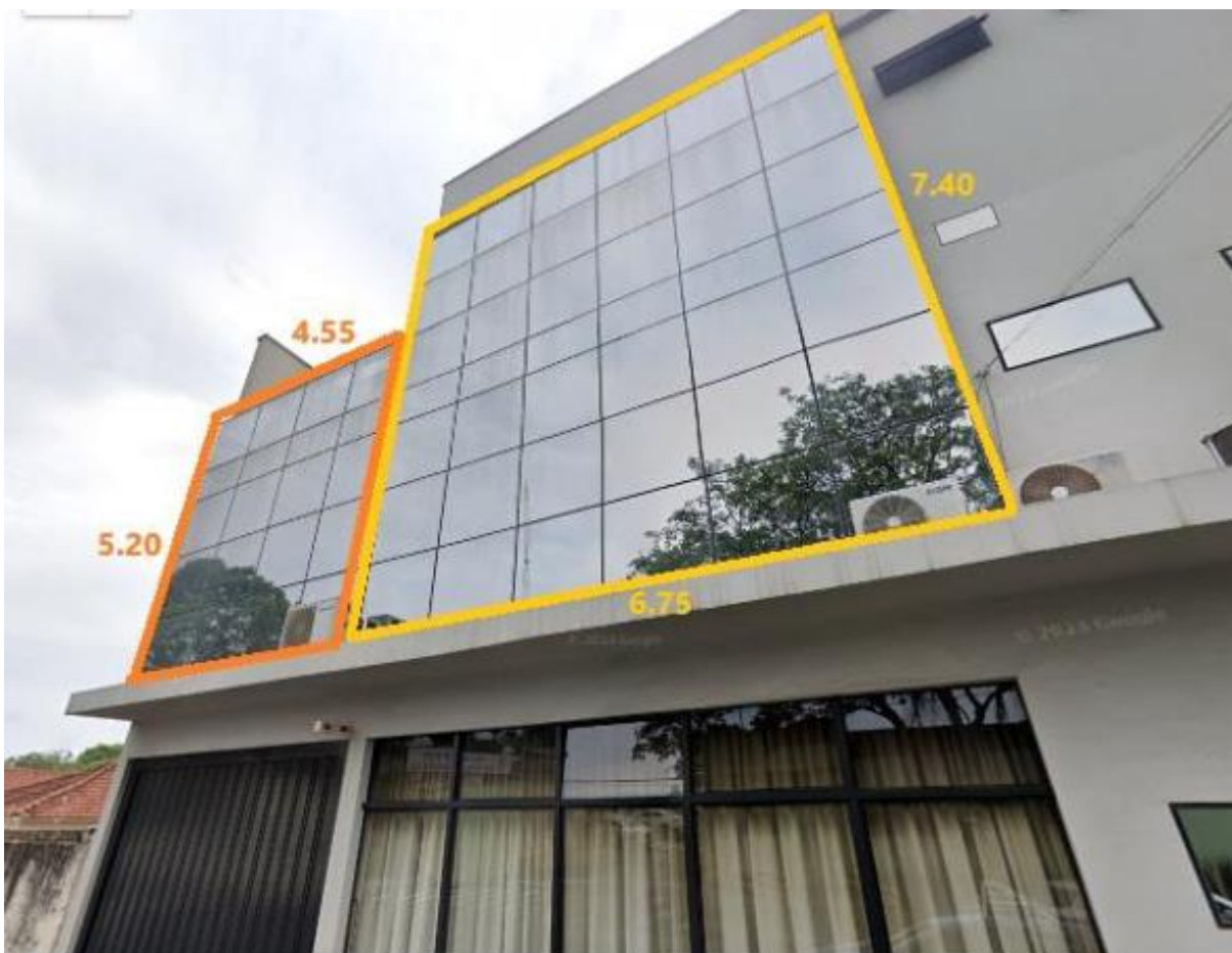
Fachada da Câmara Municipal de Lençóis Paulista (lateral da rua José Paulino da Silva)
